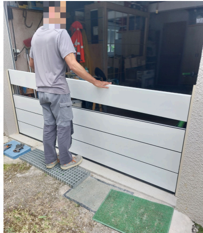
Installation de batardeaux
