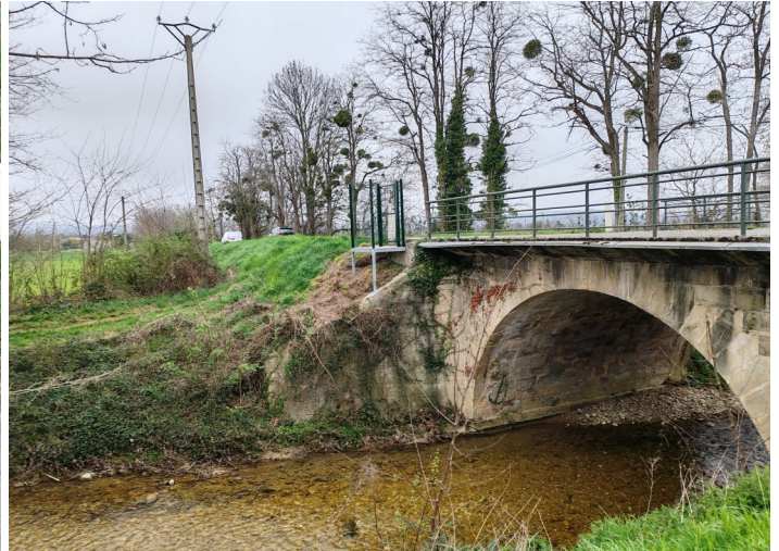
Plateforme finalisée sur la rive gauche du Criu à Verniolle (Photo ©Aquifères)
