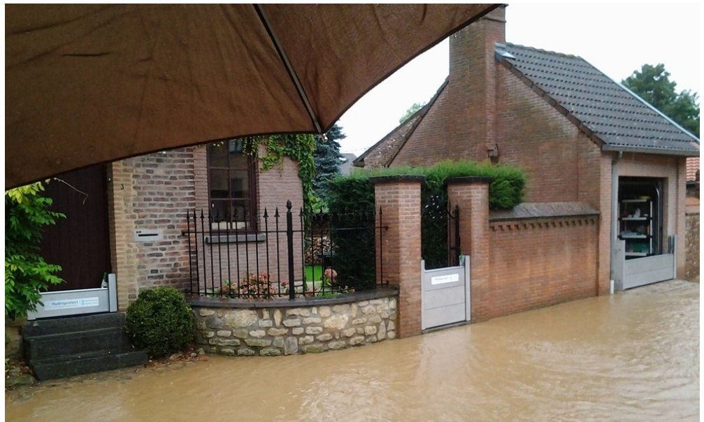
Batardeaux en action - Photographie Hydroprotect France
