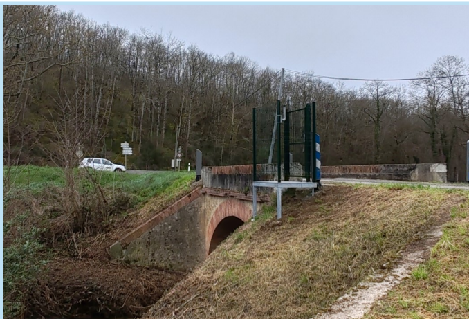
Plateforme finalisée sur la rive droite du Criu à Malléon (Photo ©Aquifères)
