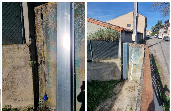
Mise en place du système d'alerte sur la Galage à Verniolle, 04 avril 2024 (Photo ©Aquifères)
