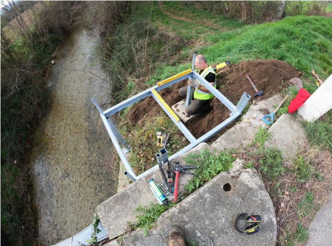
Travaux de mise en place de la plateforme à Verniolle le 18 mars 2024 (Photo ©Aquifères)
